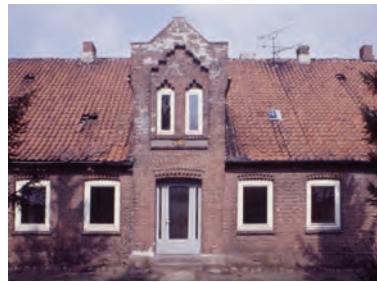
Südfassade mit Mittelrisalit, qualitativ hochwertiges Backsteinmauerwerk mit dekorativ gestaltetem Giebel des Mittelrisalits
