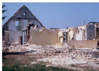
Südfassade, während des Abbruchs
