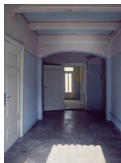
Blick vom südlichen Haupteingang in die Küche, links eine Füllungstür zur Wohnung des Oekonomenhepaars, wie alle anderen Türen des Werkhauses war auch die Küchentür eine schlichte Brettertür.
