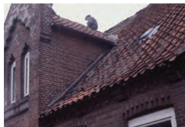
Südfassade, Mittelrisalit von Südosten, Zahnschnittgesims an der Traufe, dekorativ gemauerte Fensterstürze
